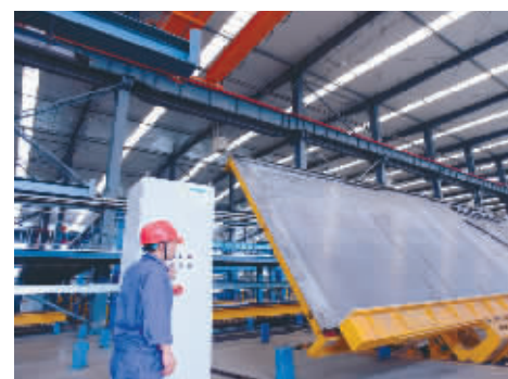
11月14日,在“国家住宅产业化基地”沈阳万融现代建筑产业有限公司,工人正在紧张工作。
