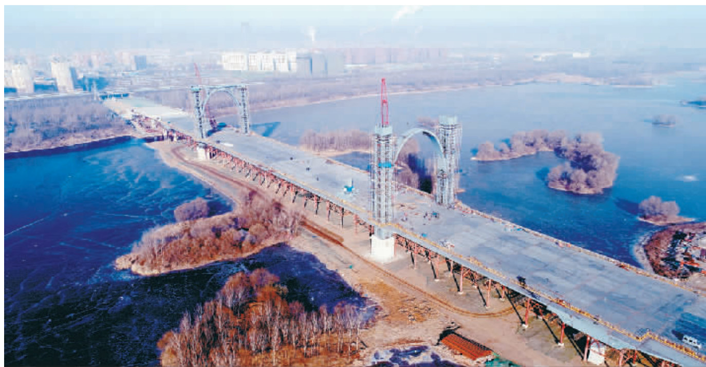
东塔桥主塔 即将完成安装
