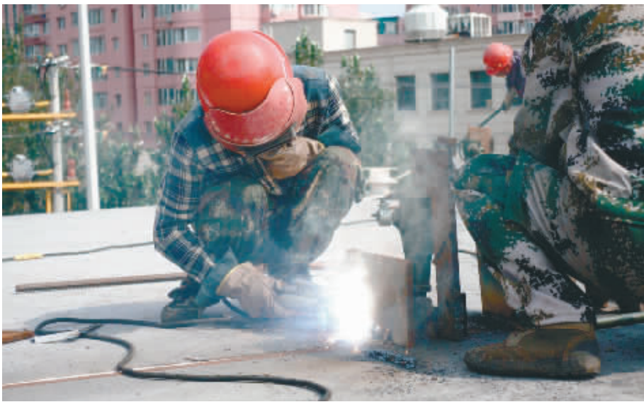
8月9日,工人们现场施工。沈阳日报、沈报融媒记者 李浩摄
