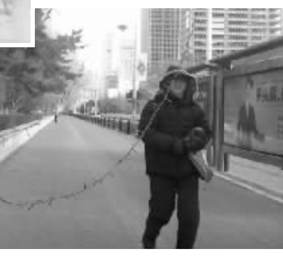
▲2月8日，中山公园东门挂在树枝上的几条彩灯电线脱落，带电的电线垂下，阻挡了人行道，行人有触电的危险。邵兵 摄
